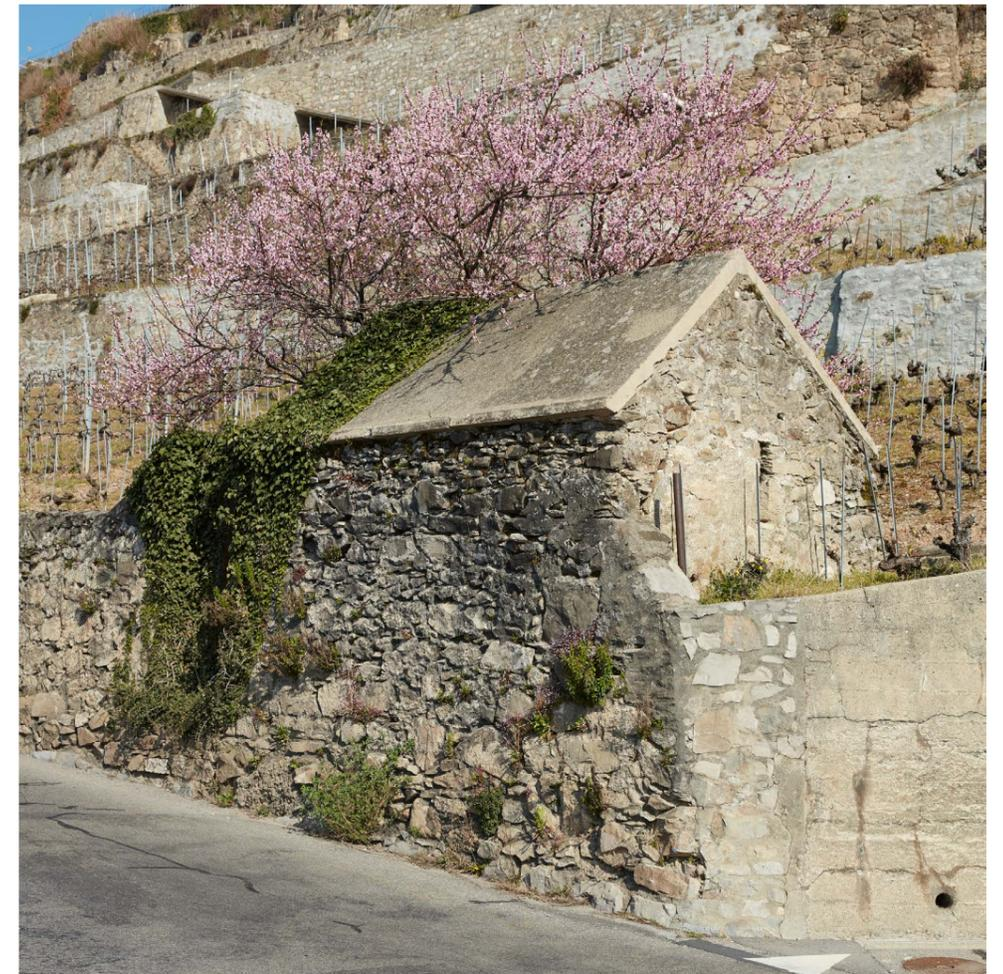
disposées en assises régulières, une épaisseur de mur équivalant au moins au tiers de la hauteur, un parement extérieur montrant un fruit et un couvrement en pierres plates ou en arrondi rejointoyé (fig. 36).
