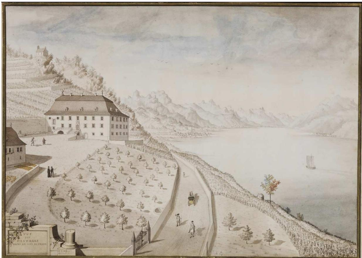
*Fig. 18 – Vue des Faverges. Aquarelle du P. Joseph Meuwly, vers 1772. Une véritable célébration de la nouvelle route et des aménagements paysagers : parapets et longs murs de soutènement sur le vignoble en pente jusqu'à la chapelle d'Ogoz.*
